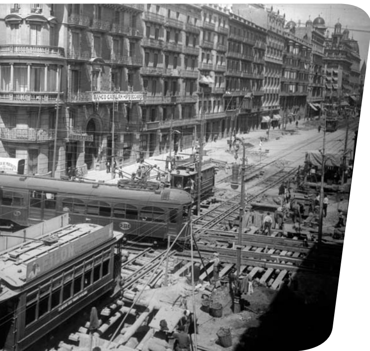
les obres de construcció del metro. Cap a 1925. Font arxiu FGC.
