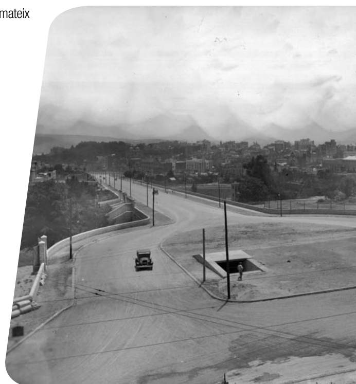
L'estació d'Avinguda del Tibidabo amb el carrer Balmes urbanitzat.
